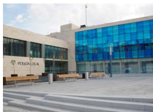
Paikallinen poliisiasema, julkisivu
